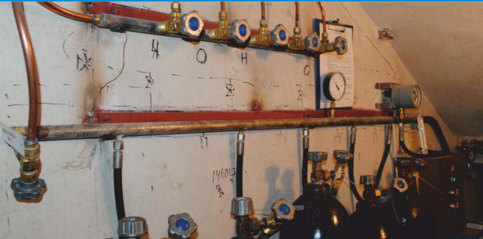
Специальное оборудование для оснащения мест газорезчика, которое позволяет безопасно подключать резаки малой и большой мощности.
